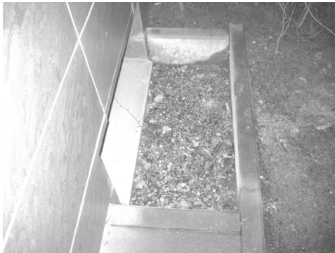
RYSUNEK 1. Światlik okienny pomieszczenia przyziemia FIGURE 1. Skylight window of basement room
