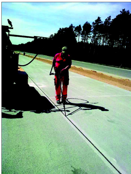
Fot. 12. Wypełnianie gorącą zalewą drogową poszerzonej do 8, 10 lub 12 mm szczeliny w nawierzchni betonowej (głębokość poszerzonych szczelin, zależna od wymaganej szerokości szczeliny, od 27 do 40 mm, a grubość zalewy na wkładkę z gumy neoprenowej: 15 do 20 mm) (fot. St. Rewiński)
