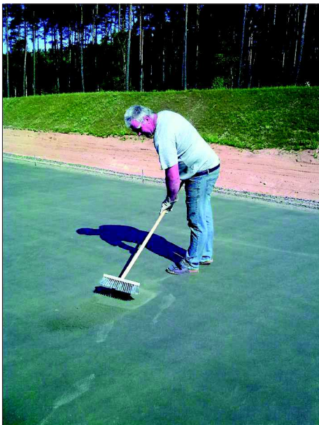
Fot. 8. Testowanie powierzchni nawierzchni przed zmiataniem warstwy zaprawy cementowo-piaskowej (fot. St. Rewiński)
