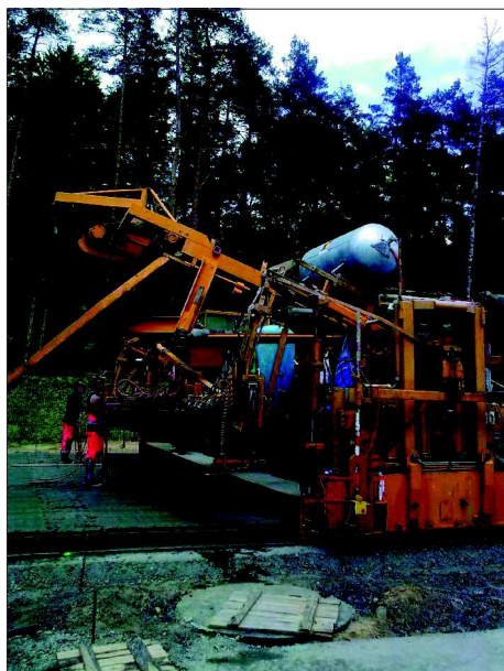
Fot. 4. Układanie dolnej warstwy nawierzchni wraz z wbudowywaniem dybli i kotew (fot. St. Rewiński)
