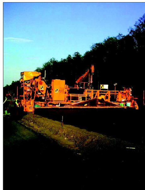
Fot. 1. Układanie podbudowy z chudego betonu z zastosowaniem rozkładarki do betonu cementowego (fot. St. Rewiński)
