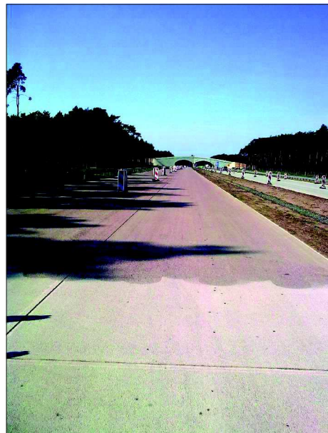
Fot. 10. Usuwanie warstewki niezwiązanej zaprawy cementowo-piaskowej strumieniem wody pod ciśnieniem (po awarii szczotek) (fot. St. Rewiński)
