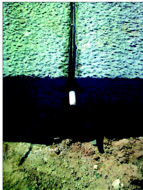
Fot. 13. Widok z boku wciśniętej wkładki uszczelniającej z gumy neoprenowej w naciętą szczelinę w nawierzchni betonowej oraz uszczelnienie zalewą drogową na gorąco (fot. St. Rewiński)
