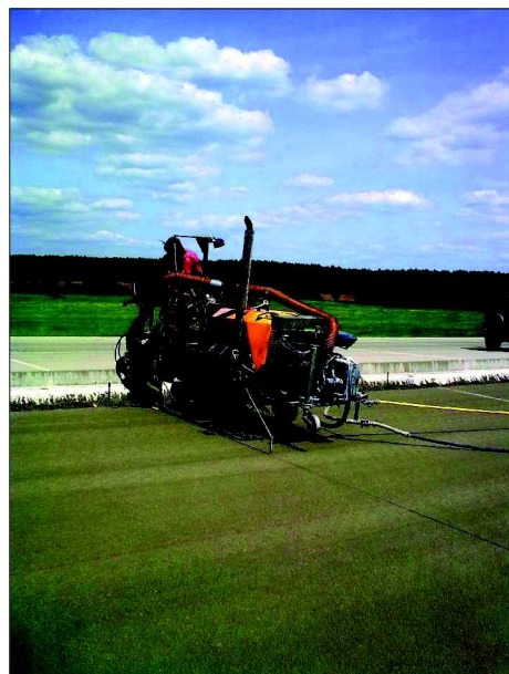
Fot. 7. Wstępne nacinanie nawierzchni na głębokość 10 cm (fot. St. Rewiński)
