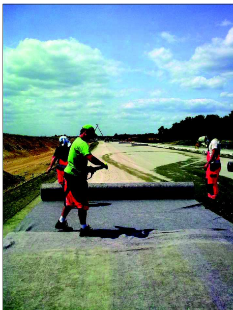
Fot. 3. Układanie oraz mocowanie geowłókniny (fot. St. Rewiński)
