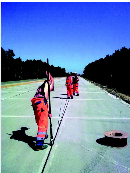
Fot. 11. Wciskanie wkładki uszczelniającej z gumy neoprenowej w naciętą szczelinę w nawierzchni betonowej (fot. St. Rewiński)
