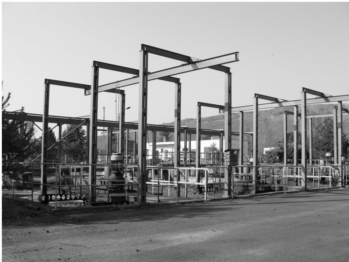
Rys. 7.1 Oczyszczalnia ścieków „Ziemowit” przed modernizacją
