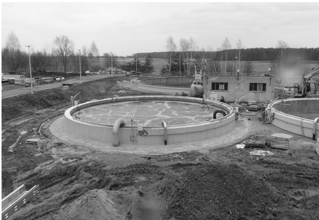
Rys. 7.3 Komora stabilizacji tlenowej w trakcie modernizacji
