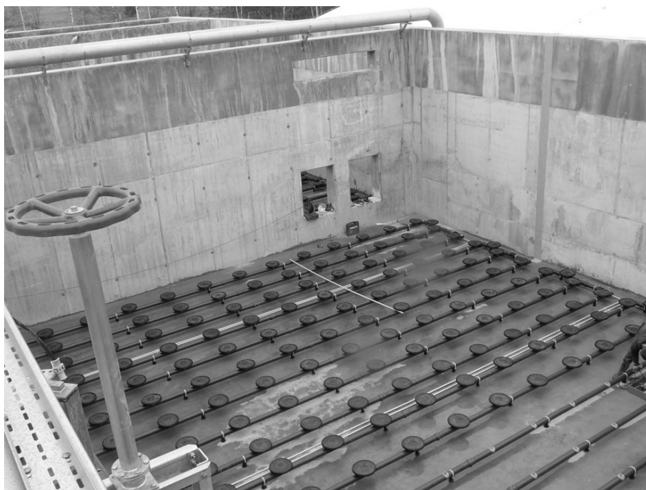
Rys. 7.4 Reaktor biologiczny w trakcie modernizacji
