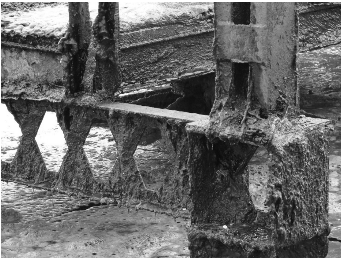
Rys. 7.2 Element konstrukcyjny podtrzymujący napęd szczotek napowietrzających przed modernizacją
