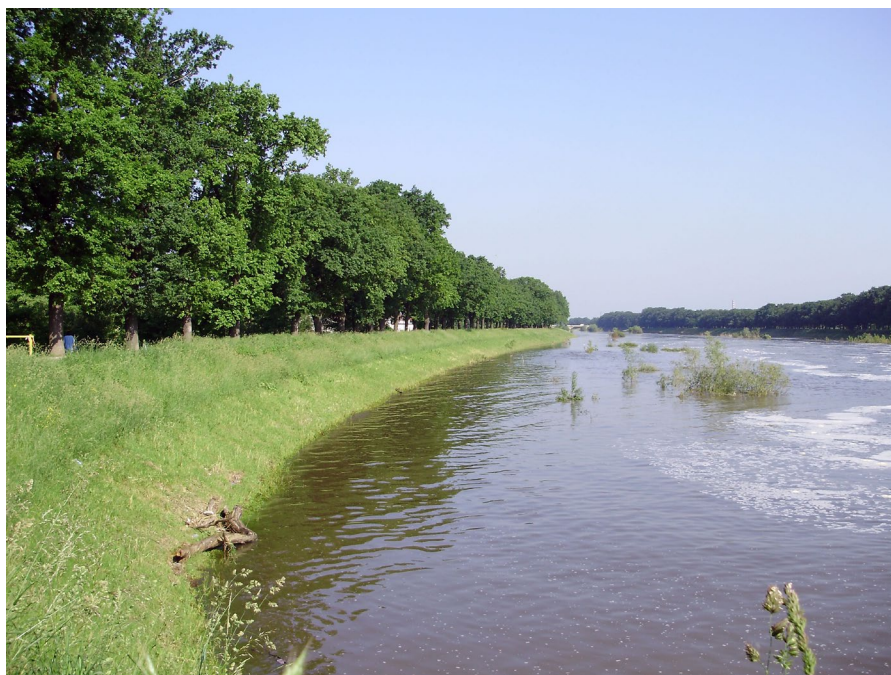
Ryc. 4. Przeciwerozijna rola roślinności. Widoczny brak uszkodzeń skarpy wału pokrytego zwartą darnią po przejściu fali powodziowej
