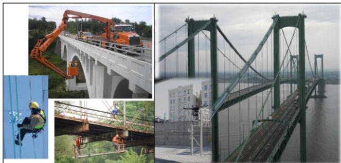
Rys. 8. Użycie drona w inspekcji mostów (źródło: Day D., 2017)
