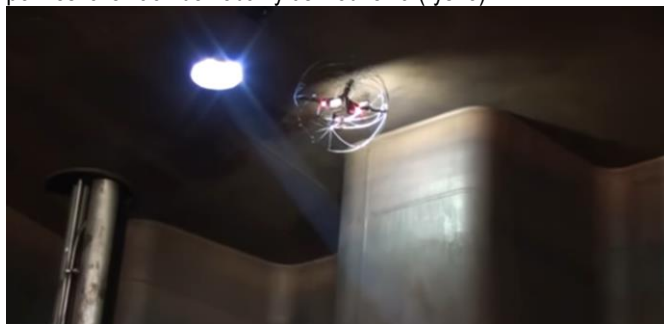
Rys. 3. Inspekcja zbiornika dronem (źródło: https://www.gospodarkamorska.pl/Stocznie,Offshore/prs-wykorzystuje-drony-do-inspekcji-statkow.html )
