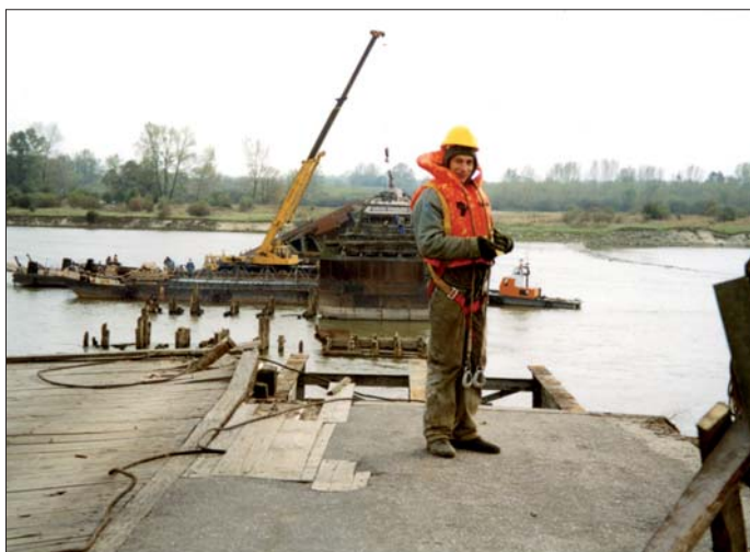
Fot. 17. Rozbiórka belkowych przęseł mostu (fot. W. Walerych 2000 r.)
