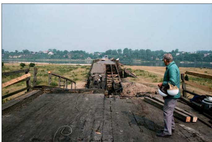
Fot. 11. Wyłączenie mostu z użytkowania wskutek pożaru (fot. M. Mistewicz 1990 r.)
