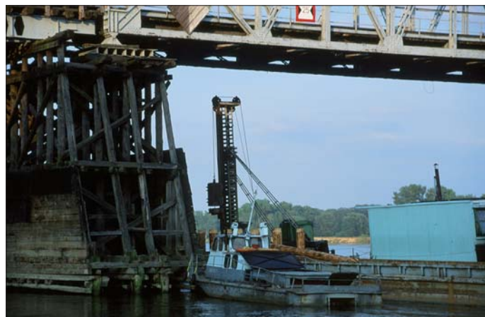
Fot. 12. Wbijanie pali drewnianych pod przęsłem żeglownym mostu (fot. M. Mistewicz 1991 r.)
