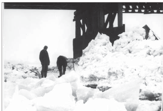
Fot. 6. Spiętrzenie lodu przed izbicą mostu w Wyszogrodzie (fot. G. Małetka 1982 r.)
