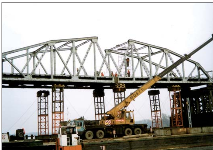
Fot. 16. Rozbiórka stalowej kratownicy przęsła nurtowego mostu (fot. W. Walerych 2000 r.)
