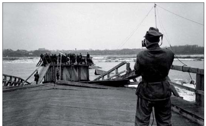
Fot. 3. Zerwane przęsło mostu podczas pochodu lodów w 1947 r. (Archiwum Szczecińskich/East News 00921173 0006)
