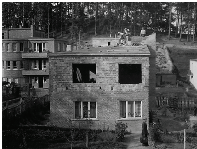
Rys. 2. Realizacja murów budynku z różnych materiałów: a) zastosowanie różnych materiałów w poziomie poszczególnych kondygnacji, b) zróżnicowanie materiałów drobnowymiarowych w poziomie pojedynczej kondygnacji (zdjęcia archiwalne będące w dyspozycji autora oraz fot. Maciej Niedostatkiwicz)
