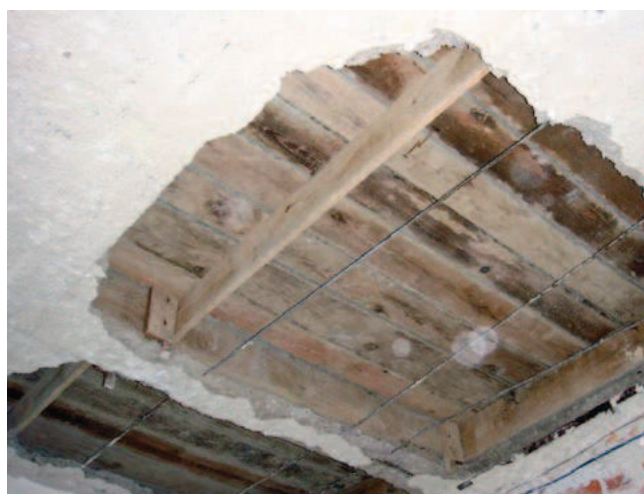
Rys. 4. Rozwiązanie międzykondygnacyjnego stropu skrzynkowego (zamkniętego): a) zarysowana płyta dolna stropu pełniąca rolę podsufitki, b) zbrojenie podsufitki prętami w zwiększonym rozstawie (fot. Maciej Niedostatkiwicz)
