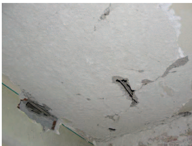
Rys. 4. Rozwiązanie międzykondygnacyjnego stropu skrzynkowego (zamkniętego): a) zarysowana płyta dolna stropu pełniąca rolę podsufitki, b) zbrojenie podsufitki prętami w zwiększonym rozstawie (fot. Maciej Niedostatkiwicz)
