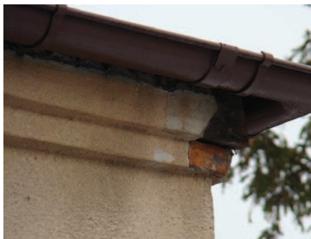
Rys. 6. Sposób oparcia drewnianej więźby dachowej na murze zewnętrznym z zastosowaniem gzymsu ceglano: a) widok, b) zbliżenie (fot. Maciej Niedostatkiewicz)
