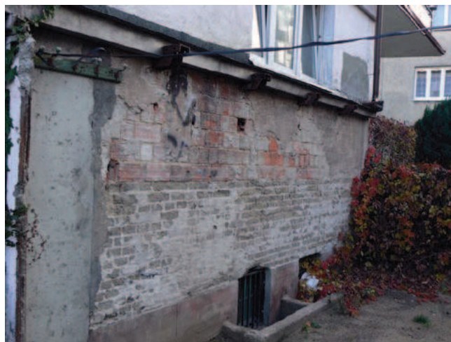
Rys. 2. Realizacja murów budynku z różnych materiałów: a) zastosowanie różnych materiałów w poziomie poszczególnych kondygnacji, b) zróżnicowanie materiałów drobnowymiarowych w poziomie pojedynczej kondygnacji (zdjęcia archiwalne będące w dyspozycji autora oraz fot. Maciej Niedostatkiwicz)
