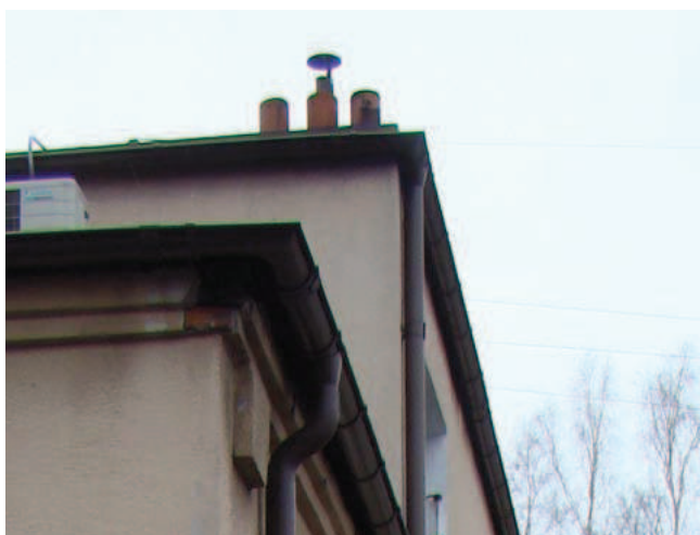
Rys. 6. Sposób oparcia drewnianej więźby dachowej na murze zewnętrznym z zastosowaniem gzymsu ceglano: a) widok, b) zbliżenie (fot. Maciej Niedostatkiewicz)
