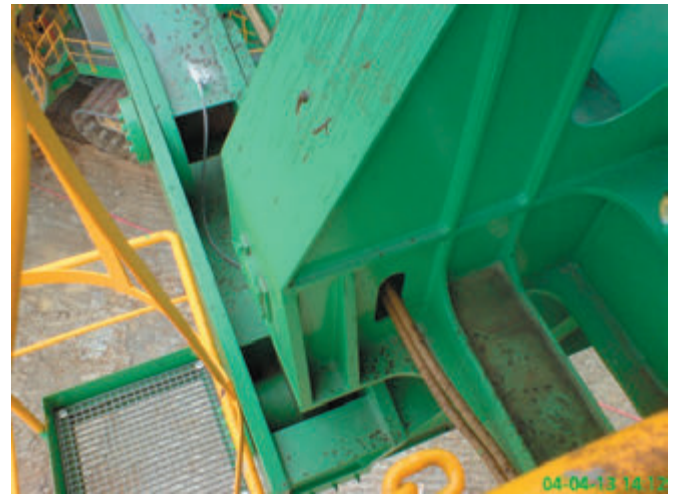
Rys. 7. Podparcie pod skrzynią przeciwwagi – koparka KWK1500.1 Fig. 7. Support under the counterweight – KWK 1500.1 excavator
