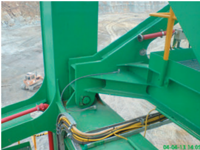
Rys. 6. Podparcie na wieży – koparka KWK1500.1 Fig. 6. Support on the tower – KWK 1500.1 excavator
