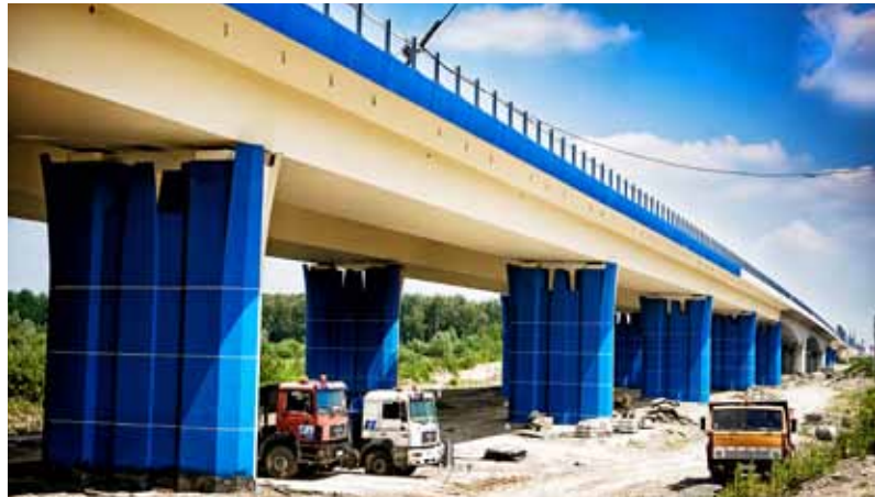
Podpory i przęsła wiaduktu pokryto farbami ochronnymi MAPEI, fot. MAPEI
