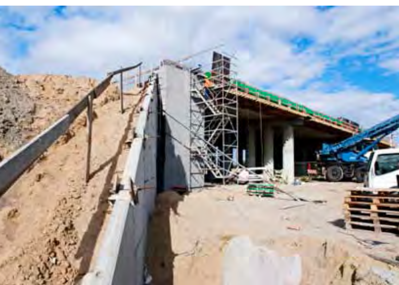
Mury oporowe zbiornika retencyjnego Srebrzysko zaizolowano zaprawą MAPELASTIC, fot. DagoTech
