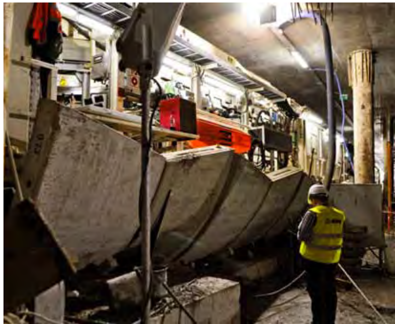
Tunele dla nowej linii warszawskiego metra drążą tarcze TBM, fot. MAPEI
