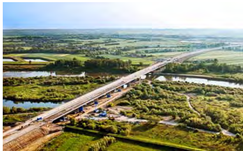
Rozwiązania MAPEI zastosowano przy 13 obiektach mostowych autostrady A4 na odcinku Wierchosławice-Krzyż, fot. MAPEI
