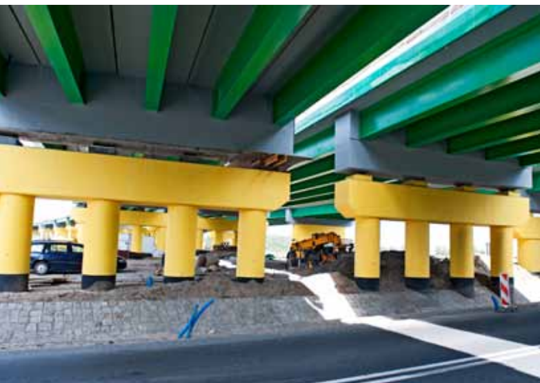
Jeden z wiaduktów Trasy Słowackiego w Gdańsku zabezpieczony powłoką ELASTOCOLOR PITTURA, fot. DagoTech
