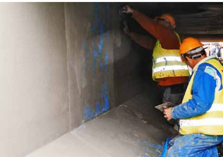
Mineralna izolacja MAPELASTIC zabezpieczyła nowy kanał rzeki Strzyży, fot. DagoTech
