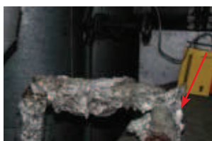
Rys. 1. i 2., Instalacje parowe izolowane sznurem azbestowym, strzałkami zaznaczono sznur azbestowy pod folią aluminiową
