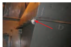
Rys. 6. Uszczelnienie sznurem azbestowym połączeń kanałów wentylacyjnych
