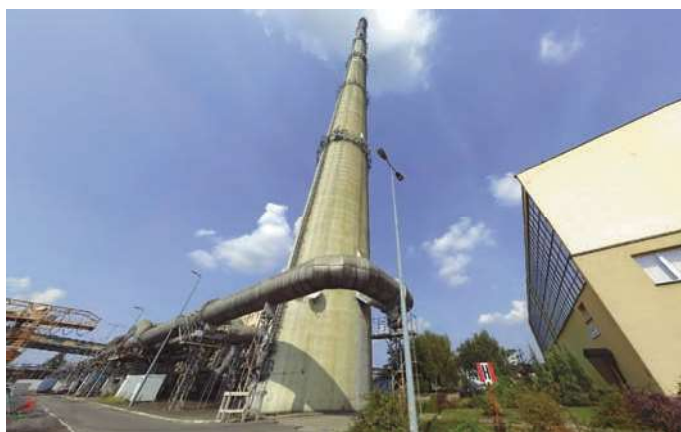
Rys. 2. Zarejestrowany przez skaner komin H=220 m w Polkowicach Fig. 2. Chimney H = 220 m in Polkowice, registered by the laser scanner
