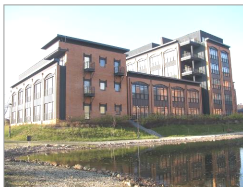
Ryc. 6. Nowe apartamentowce zbudowane przy przędzalni adaptowanej na lofty (fot. B. Wycichowska)
