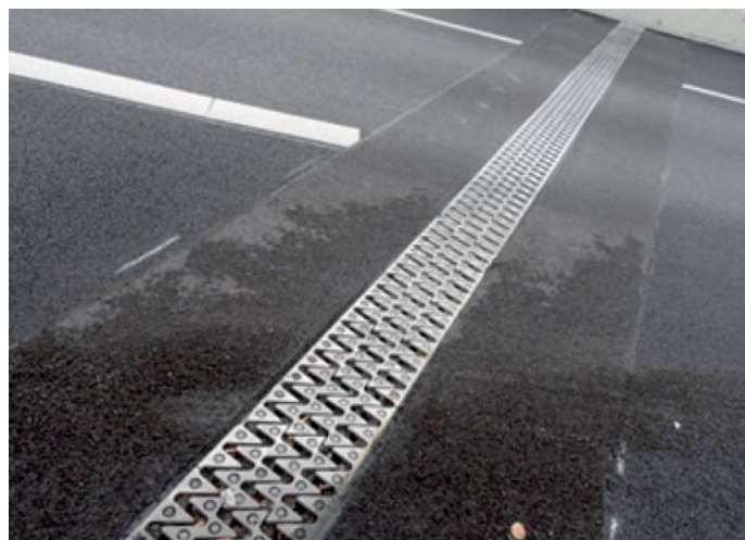
Fot. 2. Wykonanie konstrukcji przejściowej pomiędzy odcinkiem drogi na szlaku a obiektem mostowym z użyciem asfaltu lanego
