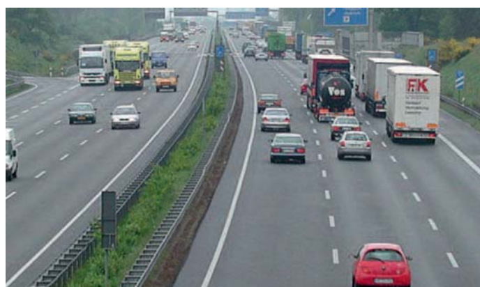
Fot. 3. Warstwa ścierną z asfaltu porowatego na autostradzie A2 na północ od Brunshwiku
