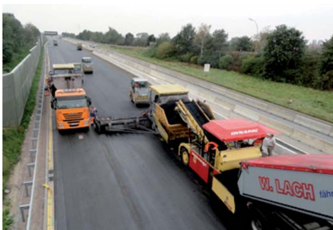
Fot. 1. Wbudowywanie asfaltu porowatego
