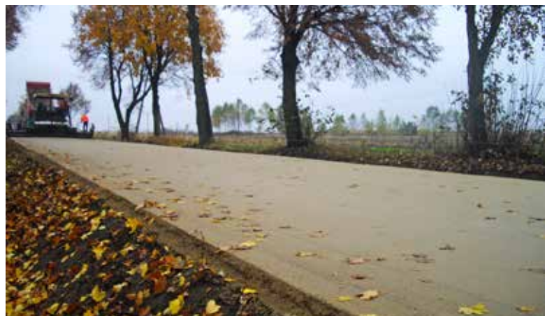
Budowa drogi betonowej w Piaskach, CEMEX Infrastruktura Sp. z o.o.
