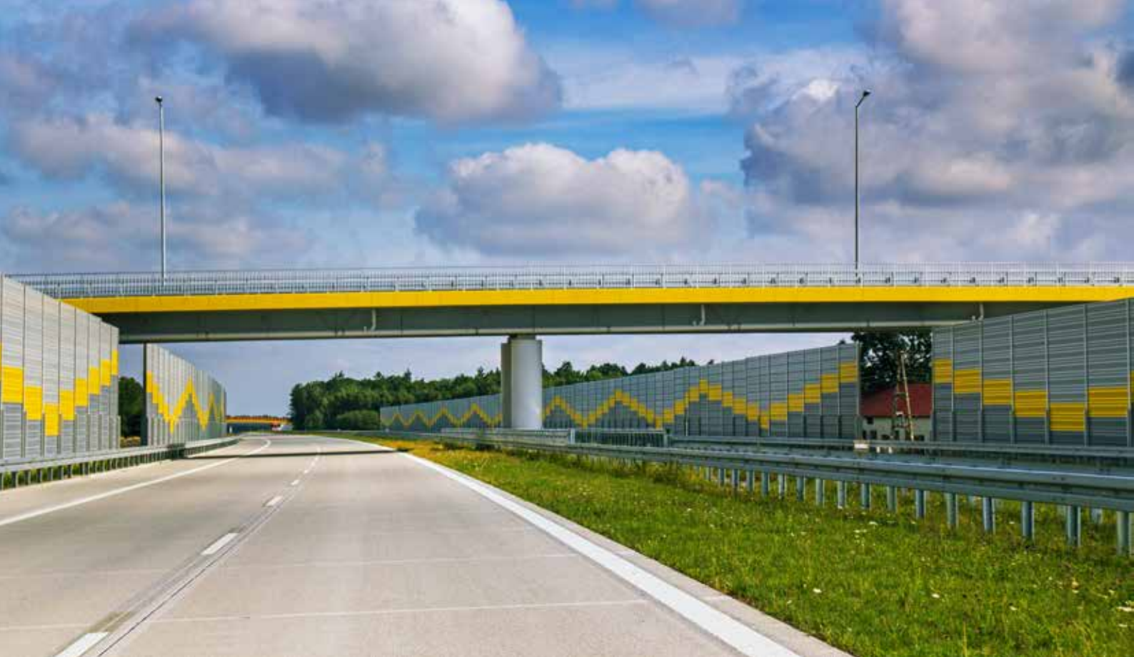
S8 Złoczew – Sieradz, fot. Strabag Sp. z o.o.
