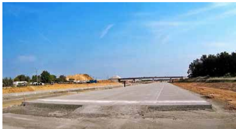
A1 Stryków – Tuszyn, fot. Strabag Sp. z o.o.
