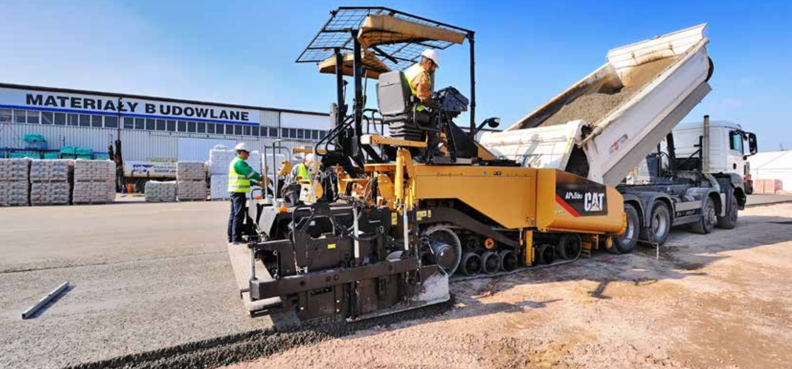
Budowa placu w Opcznie w technologii RCC, fot. LafargeHolcim
