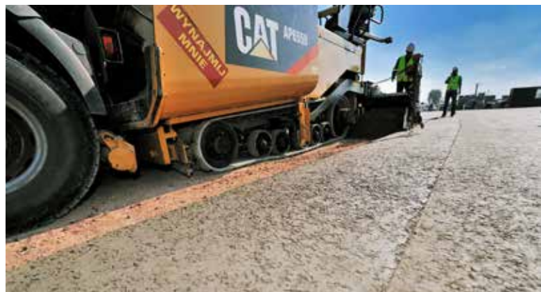
Budowa placu w Opocznie w technologii RCC, fot. LafargeHolcim
