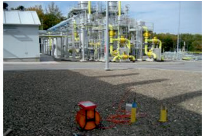
Rys.4 Pomiary kontrolne po ukończeniu Inwestycji 07-2012 Fig.4 Control measurements after the Investment 07-2012
