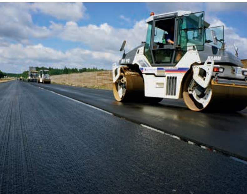
Rozkładanie warstwy przeciwspekankowej Viasaf na drodze krajowej A14 Wilno-Utena, Litwa, fot. Eurovia Polska SA
