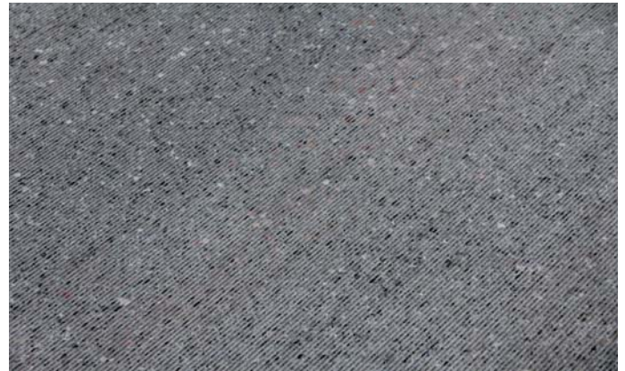
Fot. 2. Nawierzchnia betonowa NGCS poddana teksturowaniu w procesie jednokrotnego przejścia urządzenia (fot. W. Zapaśnik)
