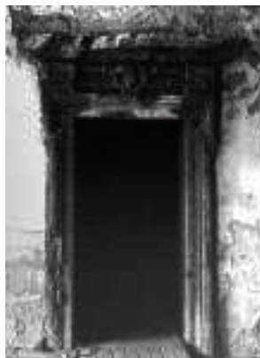
Ryc. 6. Portal w komnacie II piętra przed konserwacją Fig. 6. Portal in a second floor chamber before conservation
