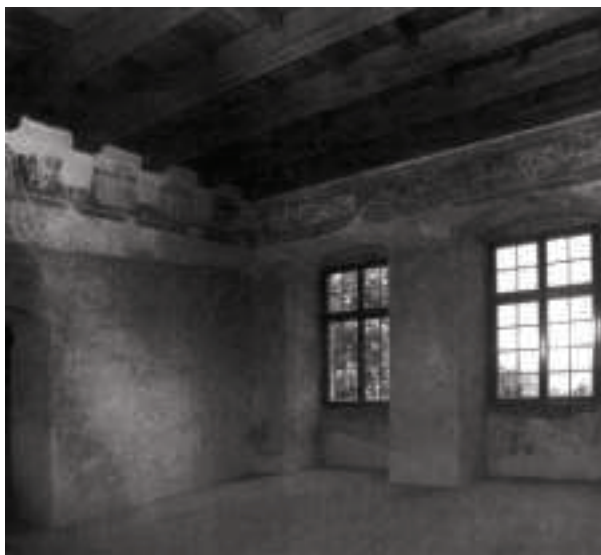
Ryc. 8. Sień przykapliczna po konserwacji Fig. 8. The chapel entrance hall after conservation
