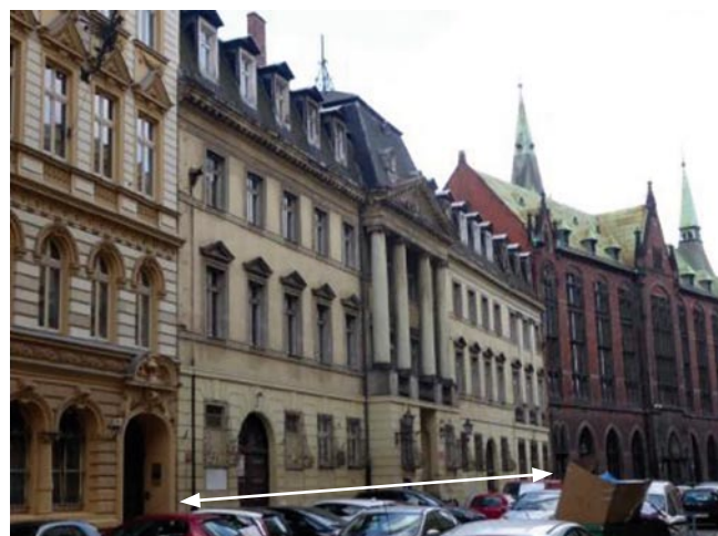
Rys. 1. Ogólny widok budynku dawnego pałacu od strony ul. Szajnochy we Wrocławiu (oznaczony strzałkami)
