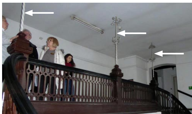
Rys. 4. Pręty stalowe, podwieszające najwyższy podest klatki schodowej do stropu Kleina (oznaczono strzałkami)
