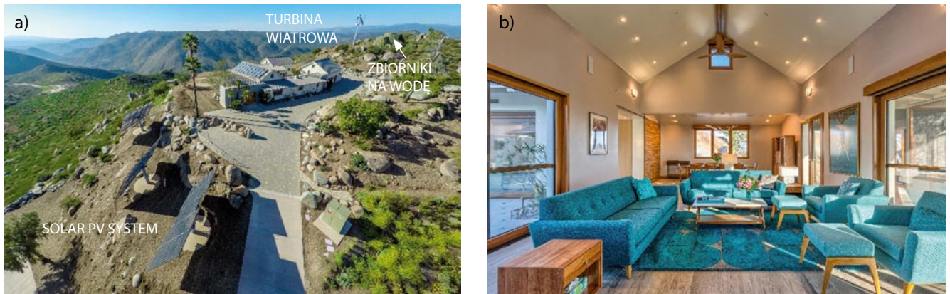
Rys. 6. Położenie posiadłości Casa Aguila z widocznymi panelami solarnymi (22,1 KW), turbiną wiatrową (3,2 KW) i zbiornikami na wodę o pojemności 10 000 galonów każdy (a), salon [8] (b)
