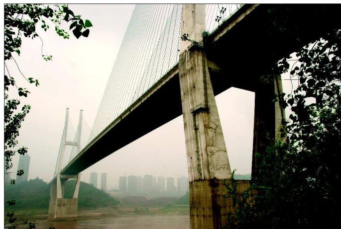
Fot. 20. Most Dafosi nad Jangcy w Chongqing
