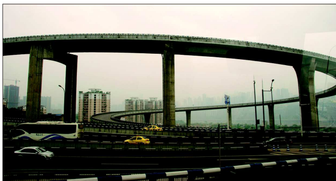
Fot. 17. Spiralne estakady dojazdowe do mostu Caiyuanba
