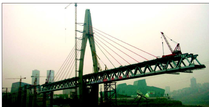
Fot. 27. Most Qianximen przez Jialing w Chongqing w budowie
