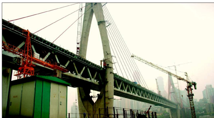
Fot. 26. Most Dongshuimen przez Jangcy w Chongqing w budowie
