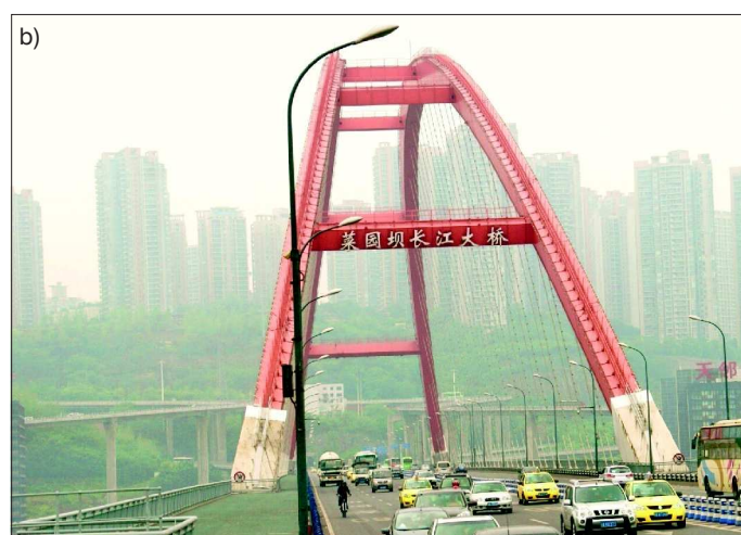
Fot. 16. Most Caiyuanba nad Jangcy w Chongqing: a) widok z nabrzeża, b) portal zjazdowy z mostu
