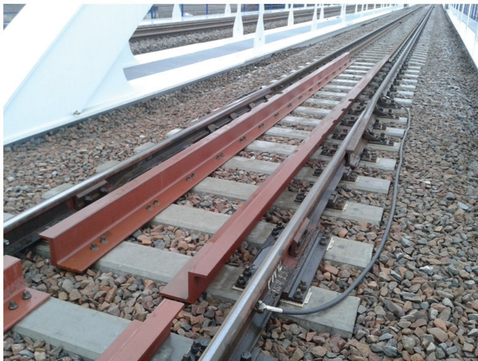
Fot. 1. Usunięte przyrządy wyrównawcze na analizowanym obiekcie
