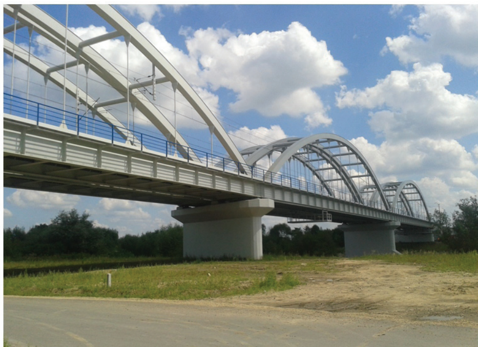
Fot. 2. Analizowany obiekt na rzece Wisłocze (trzecie przęsło znajduje się nad rzeką), na linii E30, km 108,400 (w pobliżu Dębicy)
