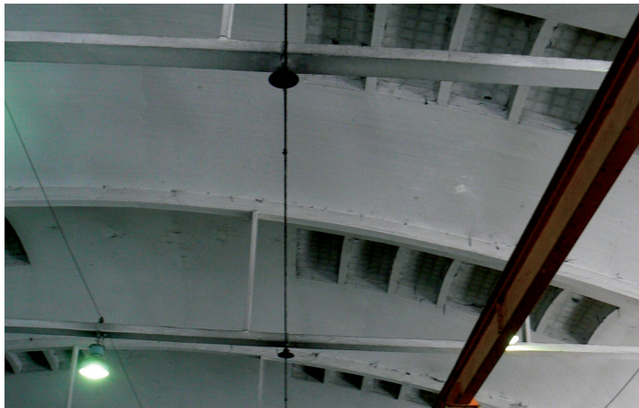
Rys. 3. Płaska sieć trakcyjna w lokomotywni
