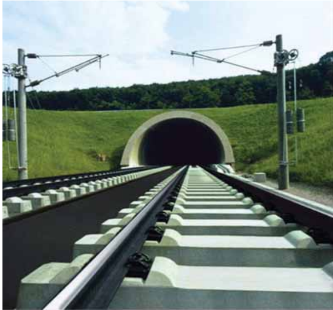
Fot. 1. Nawierzchnia GETRAC z systemem warstw asfaltowych na kolejach niemieckich
