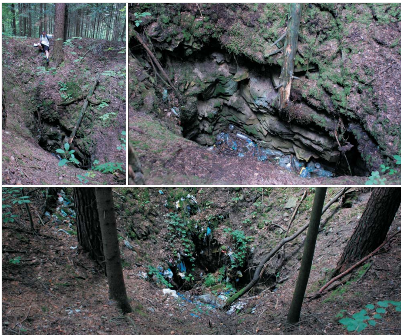
Ryc. 8. Szyby kopalniane zaczopowane osadami, materią organiczną i odpadami. Fot. G. Pabian, 2019 Fig. 8. Mining shafts plugged by sediments, organic matter and wastes. Photos by G. Pabian, 2019
