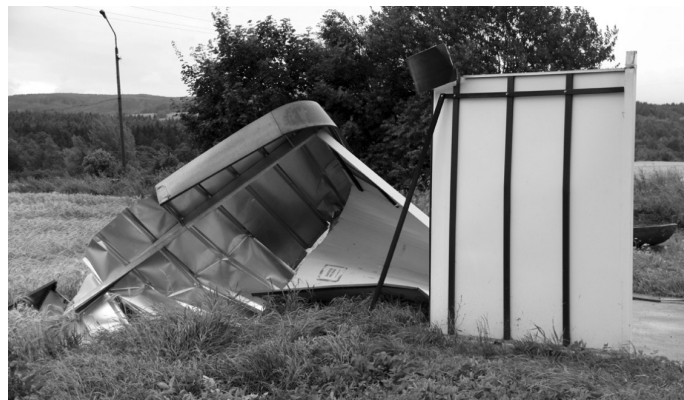
Fot. 4. Widok całkowicie zniszczonej wiaty przystankowej po nawałnicy Źródło: [16]
