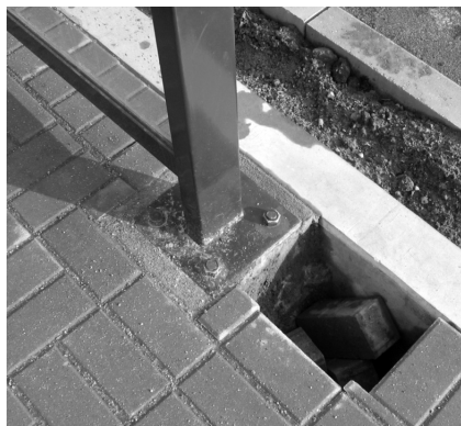
Fot. 2. Fundament punktowy wiaty przystankowej
