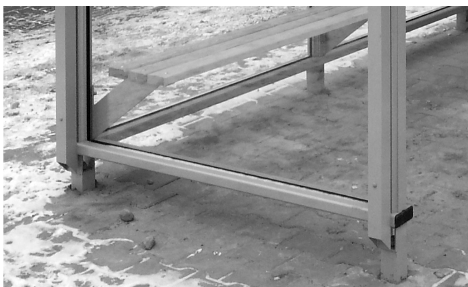
Fot. 11. Odprowadzenie wody opadowej z dachu wiaty za pomocą rur spustowych
