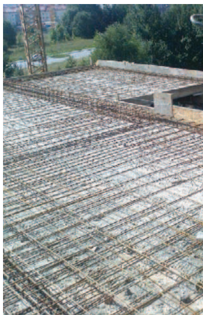
Rys. 25. Przedłużenie tarczy stropu – płyta wspornikowa balkonu zaszalowana jedynie na okalających krawędziach w płaszczyźnie wertykalnej (foto archiwum autora)
