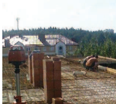
Rys. 26. Montaż konstrukcji tarczy stropu wykonanej w technologii żelbetowej zespolonej, częściowo prefabrykowanej wraz z płytą wspornikową balkonu, jako przedłużenie płaszczyzny poziomej stropu poza obrys budynku (foto archiwum autora)
