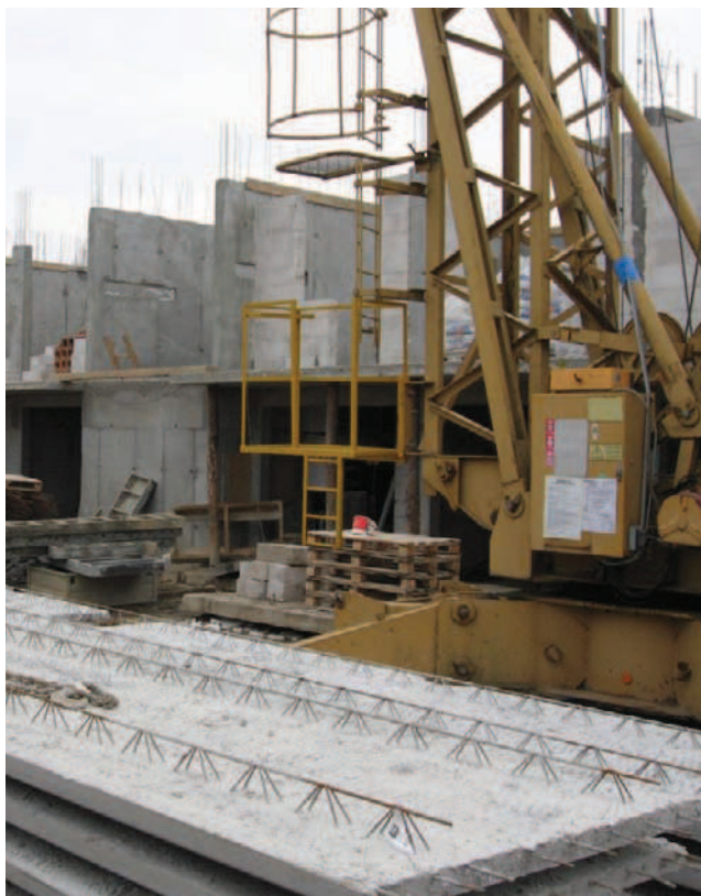
Rys. 29. Płyty stropu zespolonego przygotowane do montażu na placu budowy. W płaszczyźnie konstrukcji stropu nad parterem widoczne wykonane w technologii zespolonej płyty wspornikowe balkonów. Widoczne wsparcie teleskopowe oraz przy pomocy okrągłaków (oparcie po 28-dniowym, technologicznym procesie wiązania nadbetonu – stąd brak podłużnic). Podpory w tym wypadku służą jako wsparcie dla montażu płyt balkonowych wyższych kondygnacji (foto archiwum autora)
