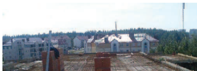
Rys. 27. Faza montażu konstrukcji tarczy stropu wykonanej w technologii żelbetowej zespolonej, częściowo prefabrykowanej – widoczne dwie zbrojone płyty wspornikowe balkonu, jako przedłużenie płaszczyzny tarczy poziomej – lewa i prawa strona tarczy (foto archiwum autora)
