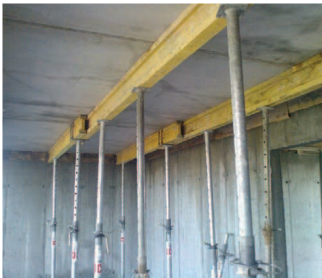
Rys. 28. Konstrukcja montażowa stropu zespolonego. Dzięki charakterystycznej technologii konstrukcji, strop przed zespoleniem jest podpierany jedynie za pomocą ryg (podłużnic) wspartych na teleskopach (foto archiwum autora)
