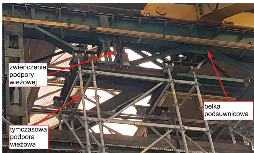
Rysunek 5. Widok tymczasowego podparcia belek podsuwnicowych
