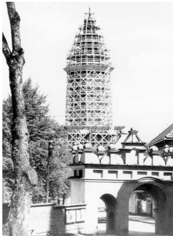
Rys. 11. Wieża ratuszowa w rusztowaniach w 1998 r. Fot. T. Ślawnicki. Wg Ślawnicki T., Biecz , 1999-2000
