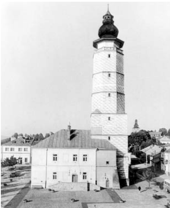
Rys. 10. Wieża ratuszowa i ratusz od strony wsch. po pracach konserwatorskich. Na pierwszym planie zarys wschodniego skrzydła ratusza, zaznaczony w nawierzchni rynku, po przebudowie w 1971 r. Fot. Archiwum WO SOZ w Krakowie
