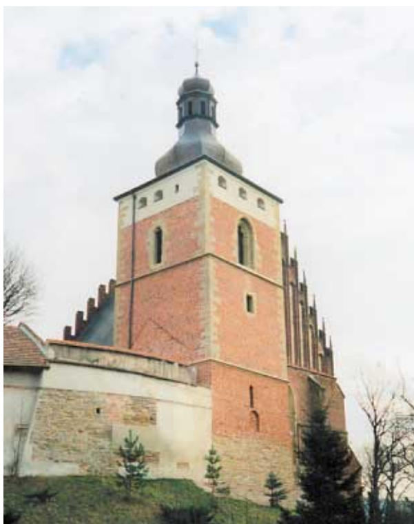
Rys. 6. Wieża – dzwonnica przy kościele farnym po pracach konserwatorskich w 2000 r. Widok od strony zach. Fot. Archiwum WO SOZ w Krakowie
