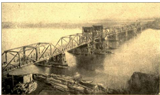
Fot. 10. Most przez Wisłę w Wyszogrodzie po przebudowie (S. Skwierczyński, Przebudowa mostu... , Wiad. Stow. Czł. PKD, 1930, rys. 6)
