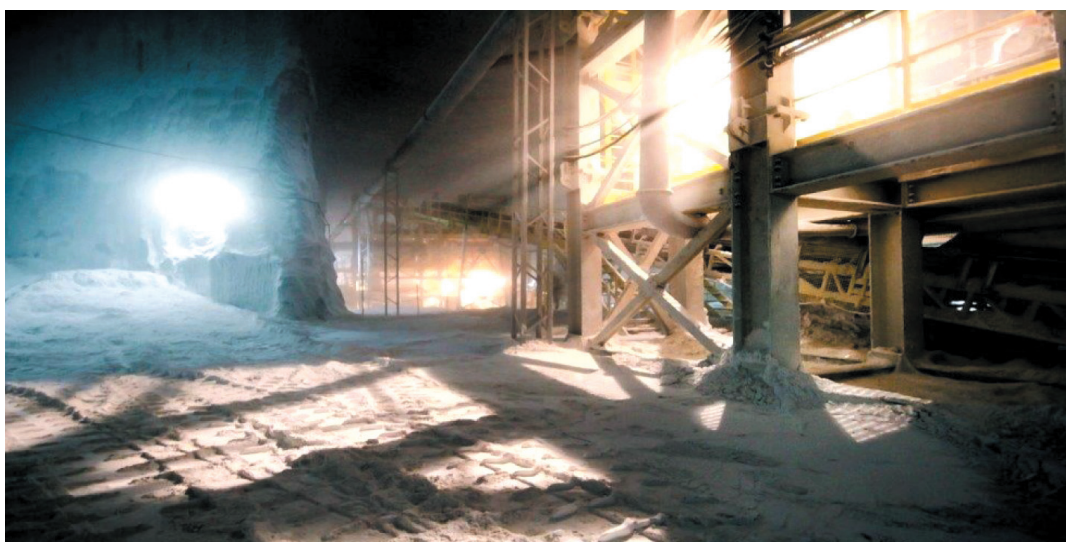
Rys. 17. Zakład przeróbki soli
