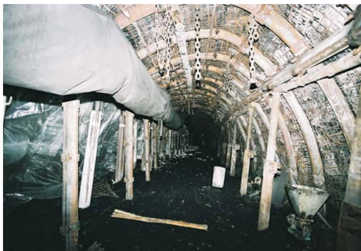
Rys. 15. Widok chodnika 23b w pokładzie 405/1 za frontem ściany
