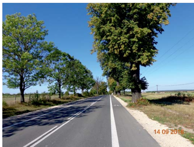
Fot. 4. Pas rowerowy w ciągu drogi
