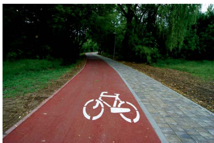
Fot. 8. Droga rowerowa z mieszanki mineralno-asfaltowej barwionej
