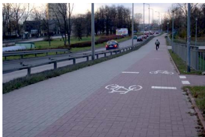
Fot. 9. Droga rowerowa z kostki betonowej
