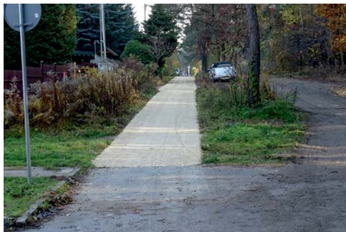
Fot. 10. Droga rowerowa z kruszywa
