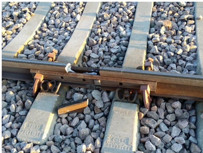
Rys. 3. Pęknięta szyna. [Archiwum Instytutu Kolejnictwa]
