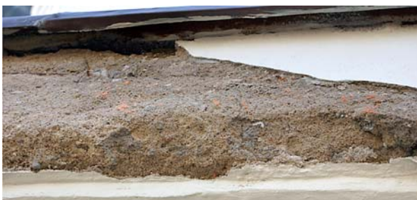
Ryc. 3. Odspojone fragmenty gzymsu, w tym części z lat 60. Fig. 3. Elements of the debonded cornices, including element from the 1960s
