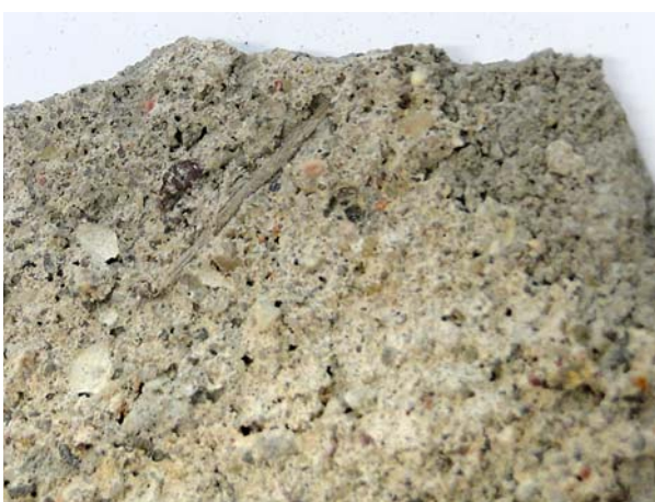
Ryc. 10. Fragment próbki nr 2. Mocno porowaty stary beton, widoczne wtrącenia drewniane
