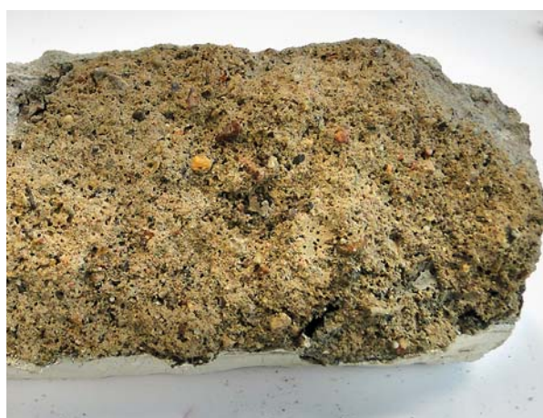
Ryc. 12. Fragment próbki nr 5. Mocno porowaty stary beton
