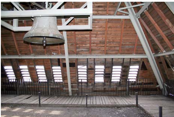
Ryc. 9. Otwory oświetlające i wentylujące poddasze w połaciach dachu nad wieżą południową. Dach o konstrukcji stalowo-drewnianej. Widoczna stalowa konstrukcja zawiesia dzwonu
