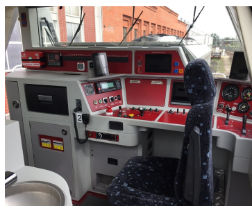
Rys. 16. Kabina maszynisty zmodernizowanej lokomotywy 19D – widok na pulpit sterowniczy 2 Fig. 16. Driver's cab of modernized 19D locomotive – view of control desk 2
