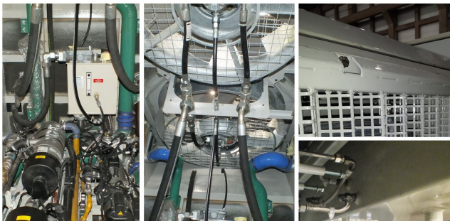
Rys. 10. Układ chłodzenia i wstępnego podgrzewania silnika spalinowego na zmodernizowanej lokomotywie 19D
