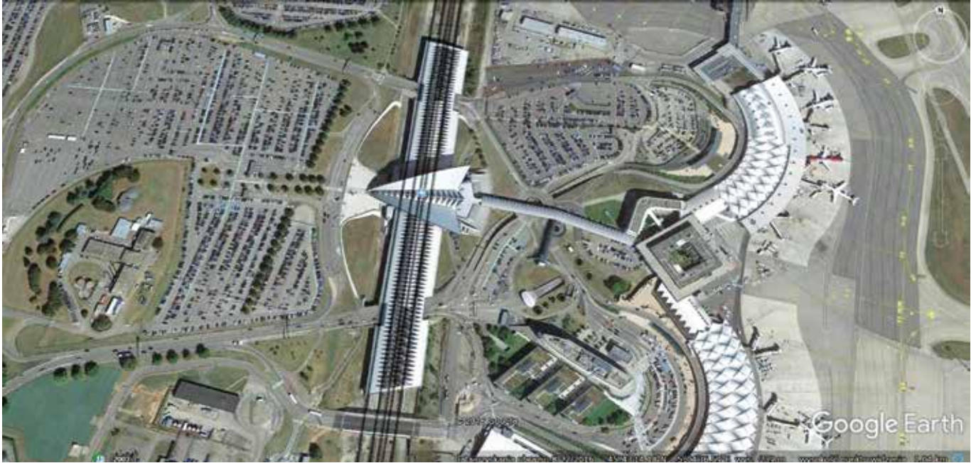
Dworzec Lyon–Saint-Exupéry TGV i terminal lotniczy na zdjęciu satelitarnym Źródło: Google Earth, 2016.
