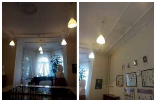
Rys. 2. Sala na parterze budynku; dekoracyjna sztukateria na suficie
