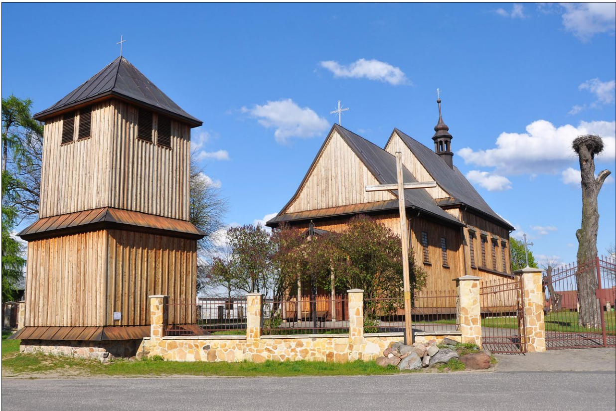
Ryc. 1. Widok kościoła w Hucie Krzeszowskiej od wejścia głównego w fasadzie zachodniej; po lewej stronie widoczna czworoboczna dzwonnica usytuowana w granicy działki oraz ogrodzenie całej parceli; fot. ze zbiorów autorki (dar S. Kłosowskiego).
