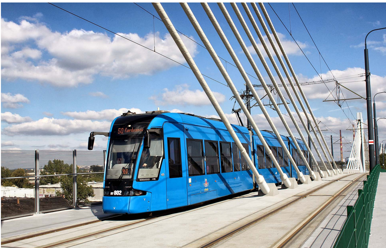
Ryc. 4. Estakada nad stacją kolejową Kraków Płaszów
