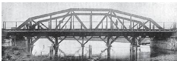
Rys. 2. Widok ogólny montowanego przęsła mostu w 1928 r. Fig. 2. General view of bridge span under assembly in 1928.
