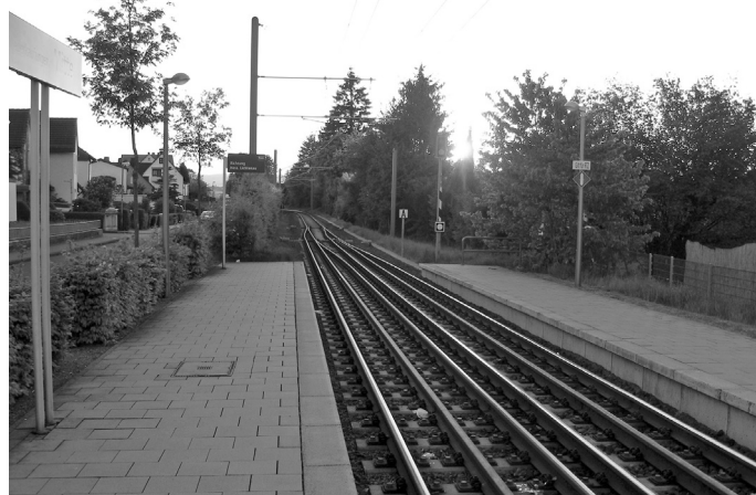
Fot. 2. Przystanek Niederkaufungen Mitte koło Kassel, widoczny splot szynowy dla wygodnej obsługi peronów pojazdami o szerokości 2,40 m przy zachowaniu skrajni kolejowej
