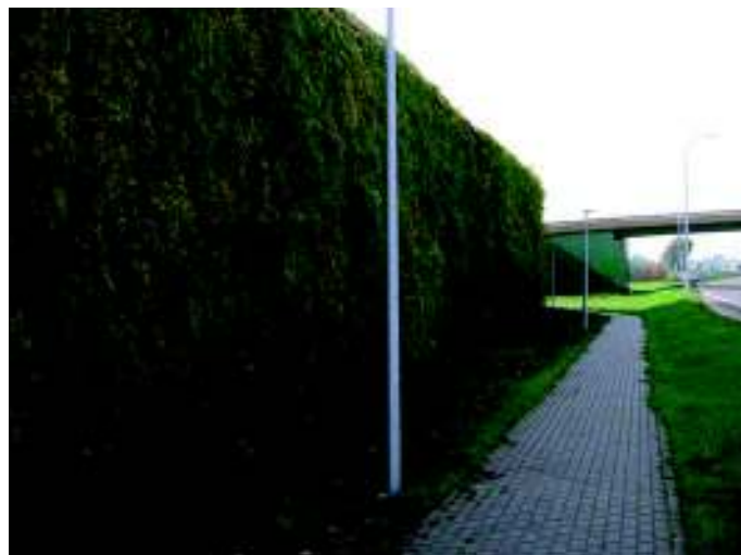
Fot. 1. Ekran akustyczny porośnięty roślinnością pełni wiele usług ekosystemowych w miejscach gdzie trudno jest wprowadzić inną roślinność (fot. Agnieszka Gawłowska)
