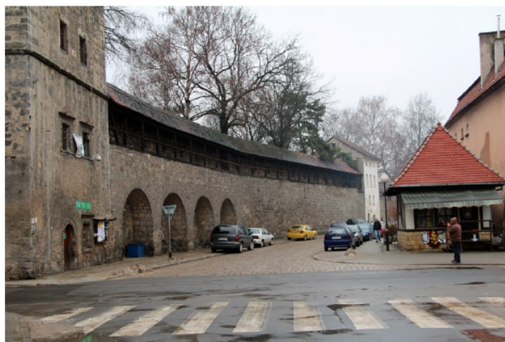
Ryc. 7. Lwówek Śląski, ganek bojowy (blanki) i hurdyce. Widok od wnętrza obwo- du obronnego (fot. autora)
