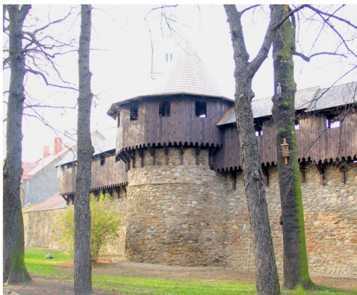
Ryc. 8. Paczków, hurdyce i machikuly, w centrum fotografii baszta. Widok z zewnątrz obwo- du obronnego (fot. autora)
