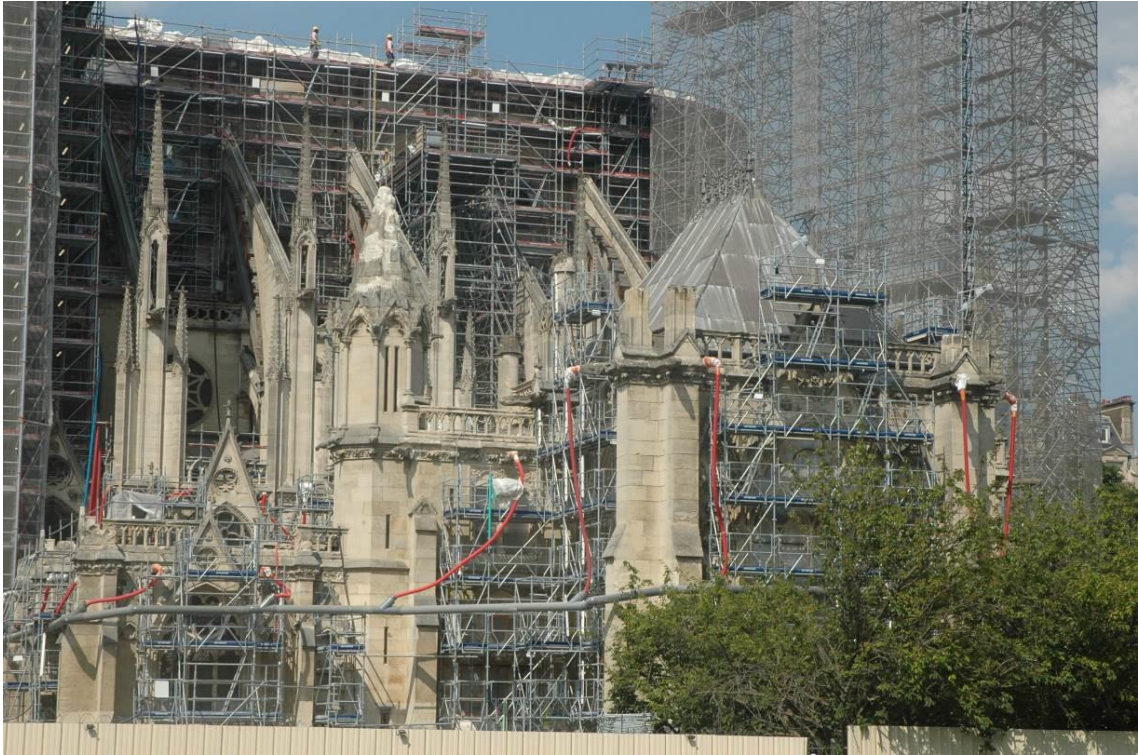
Fig. 14. Notre-Dame de Paris during reconstruction.. Author: Ch. Dupeyroux Ryc. 14. Katedra Notre-Dame w trakcie prac rekonstrukcyjnych. 2023. Autor: Ch. Dupeyroux
