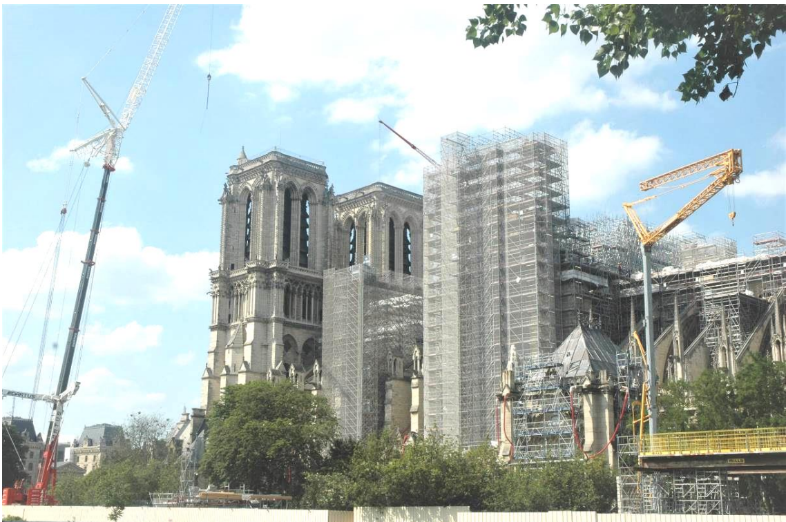
Fig. 11. Notre-Dame de Paris during reconstruction.. Author: Ch. Dupeyroux Ryc. 11. Katedra Notre-Dame w trakcie prac rekonstrukcyjnych. 2023. Autor: Ch. Dupeyroux
