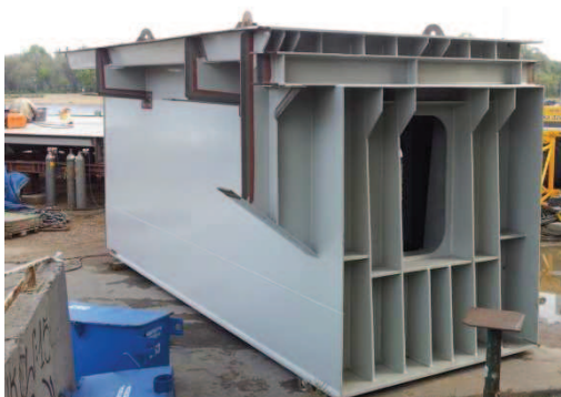
Zdjęcie 6. Zdjęcie węzła skrajnego
