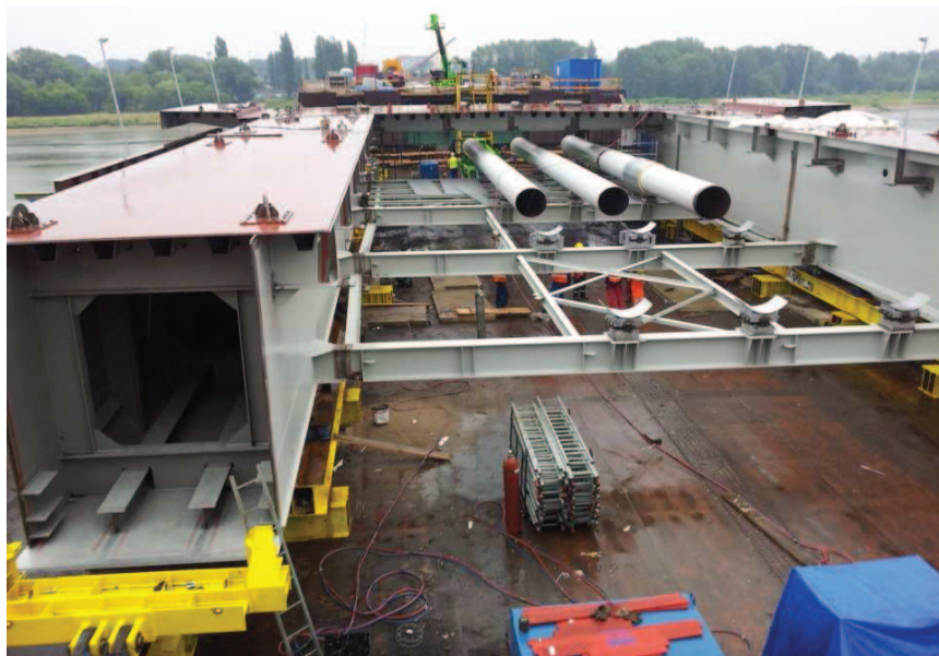
Zdjęcie 5. Widok na pomost techniczny pod płytą ortotropową.
