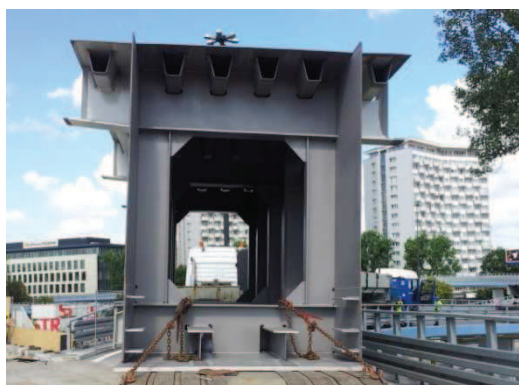
Zdjęcie 3. Zdjęcie dźwigara skrzynkowego
