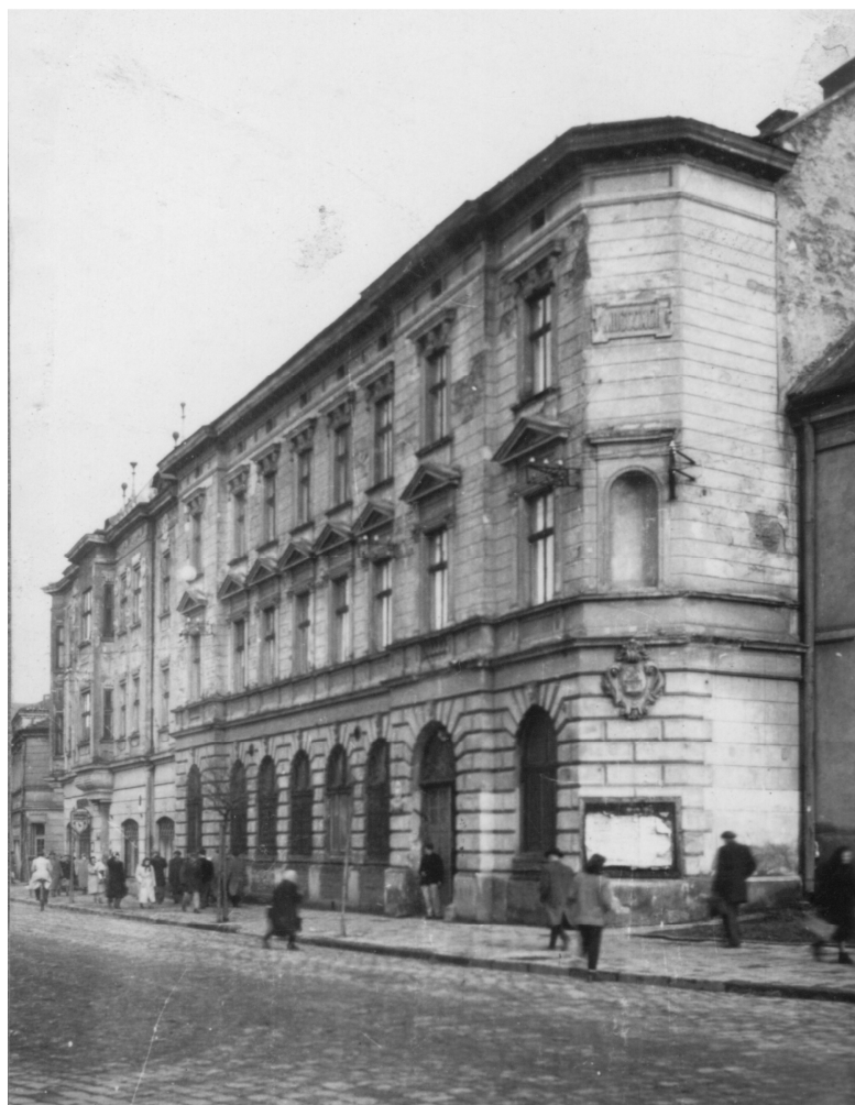
Rys. 3. Budynek rzeszowskiej Kasy Oszczędności w latach 50-tych XX wieku
