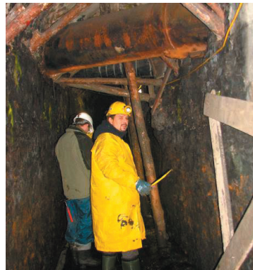
Ryc. 7. Przykłady prowadzenie inwentaryzacji i oceny makroskopowej elementów obudowy wyrobiska (Główna Kluczowa Sztolnia Dziedziczna w Zabrze i Kopalnia Ćwiczebna „SztYGarka” w Dąbrowie Górniczej)
