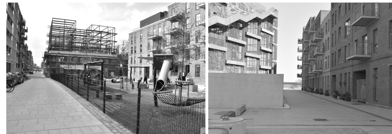
Il. 4. Park kieszonkowy w budowie. Widok w kierunku wschodnim w tle po lewej garaż wolnostojący P-hus Lüders. Źródło: materiały własne / Pocket park under construction. Eastwards view, with the P-hus Lüders detached garage building seen on the left side of the background. Image source: original work
