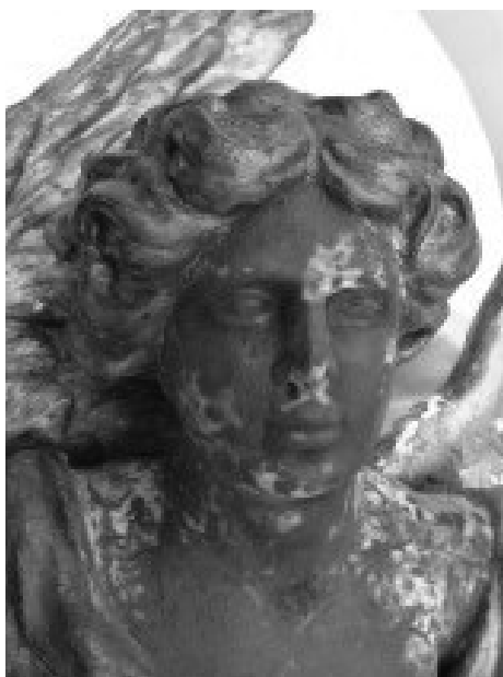
Rysunek 1.6 Plamy na rzeźbie spowodowane impregnantem
